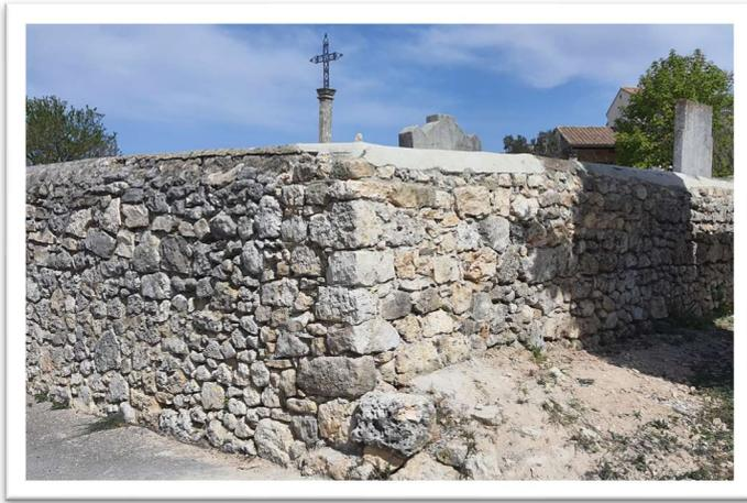
**Réfection du mur du cimetière :** Compte tenu de la menace d'éroulement de l'angle sud-est du mur du cimetière l'entreprise DIEF, a réalisé les travaux de réfection.
